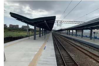
北湖站月臺提高工程
