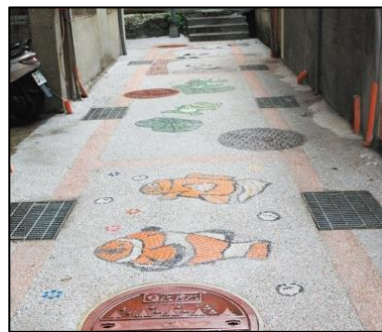
污水下水道用戶接管工程完成
