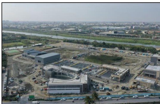
臺南市永康水源回收中心暨再生水廠 施工情形
