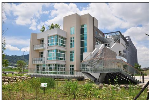
臺中市豐原水資源回收中心正式營運
